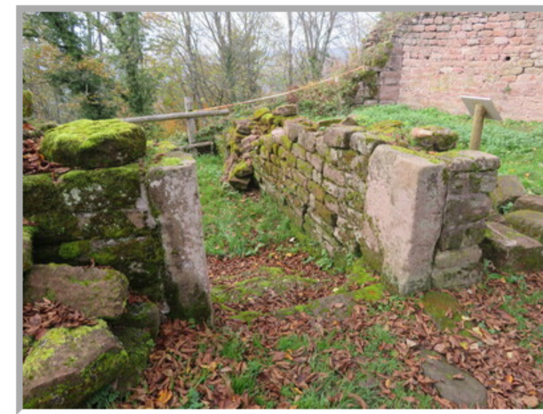
La porte avec deux montants avec feuillure largeur 20 cm, profondeur 26 puis décrochement de 3cm. Voir ci-dessous d'autres photos des montants Ce serait bien de trouver au moins un montant supplémentaire et de le remonter pour la lecture du bâti ;-)
