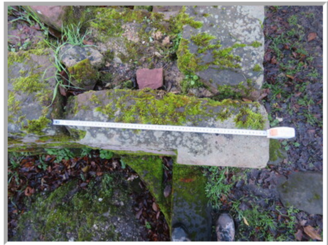
63 cm, 26 cm jusqu'à la feuillure, largeur 20 cm
