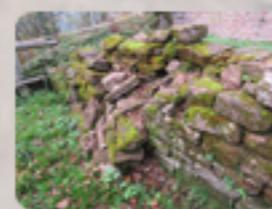
Tous les murs nécessitent une reprise des maçonneries et la réfection des arases.
