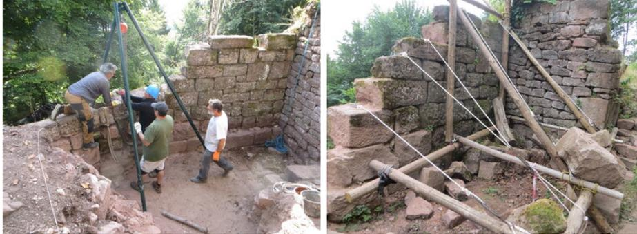
Après remontage du parement extérieur, blocage et rocaillage, l'échafaudage a pu être enlevé. Nous avons remonté le parement intérieur et rajouté
