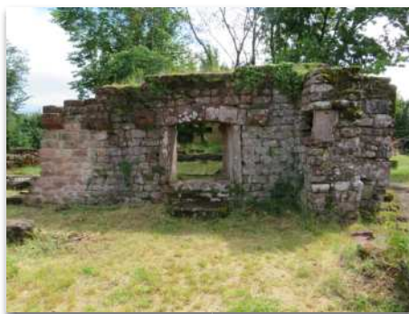
Vues du mur Trocadero depuis le Sud-Est et depuis le Nord.
